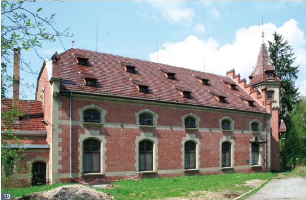
Abb. 19 Marbach, Am Mühlweg 21, ehe- maliges Wasserlaufkraftwerk
