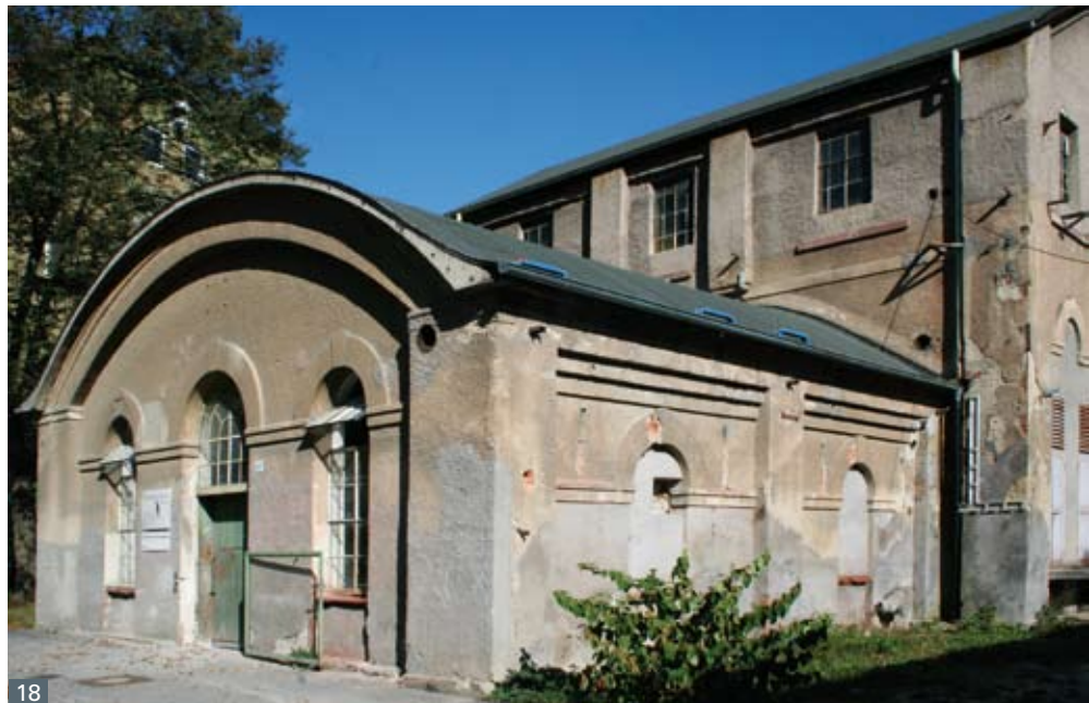
Abb. 18 Rottweil, Neckartal 207, ehemaliges Pumpenhaus der Pulverfabrik
