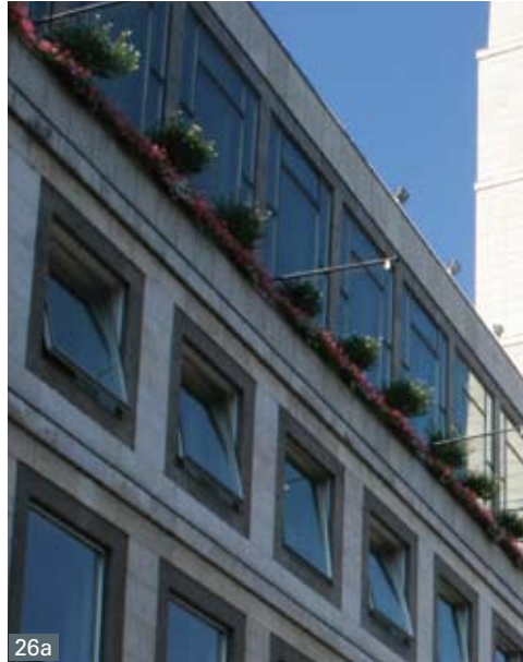
Abb. 27 Wärmetechnische Verbesserung eines Schwingflügel-Verbundfensters durch Isolierglas und Dichtung
