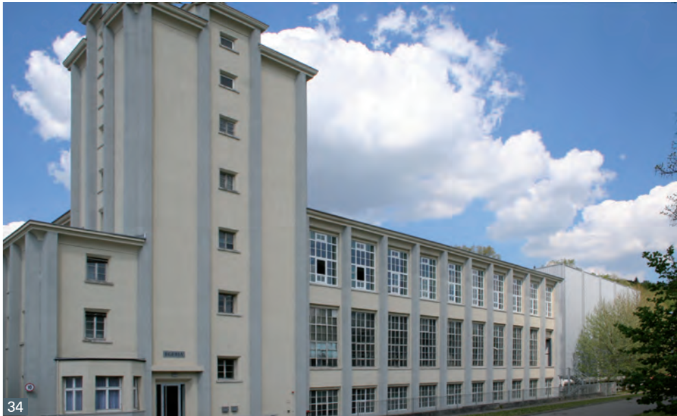
Abb. 34 und 35 Tübingen, Nürtinger Str. 63. Im 2. Obergeschoß erneuerte Fenster der ehemaligen Frottierweberei Egeria
