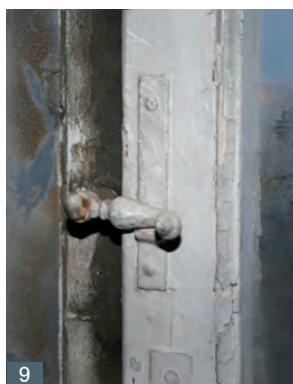
Abb. 9 bis 13 Typische Beschläge bei Panzerfenstern
