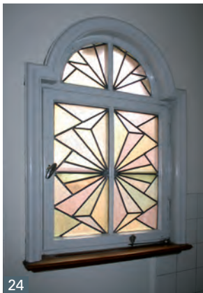
Abb. 24 bis 27 Albstadt, Herderstr. 6 und Untertürkheim, Gehrenwaldstr. 49: Verbundfenster, nur das halbrunde Oberlicht hat eine Panzerverglasung
