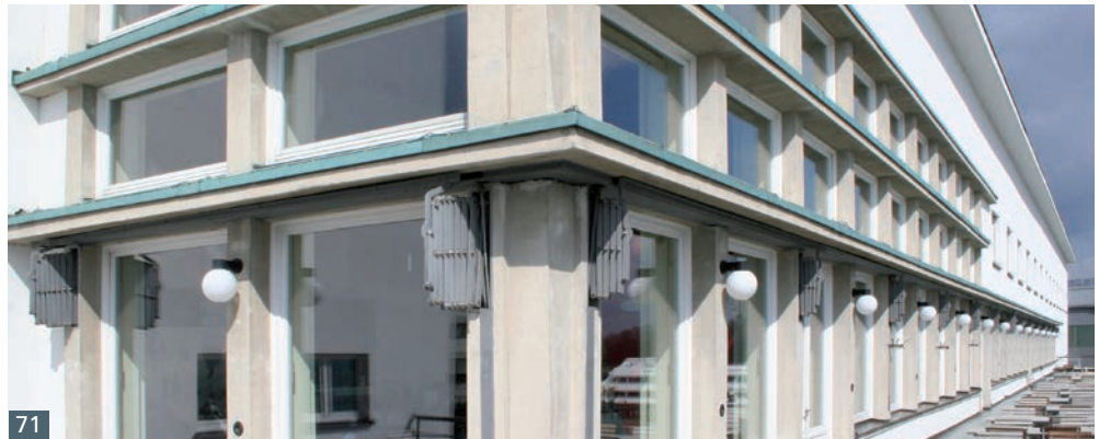
Abb. 72 Friedrichshafen, Hafenbahnhof, bauzeitliche Vertikalschiebefenster von 1934 im ehemaligen Kiosk.
