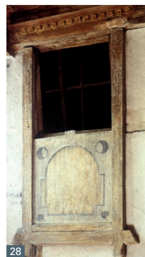
Abb. 24 Tübingen, Judengasse. Fenstererker mit Ziehläden, rekonstruiert.
