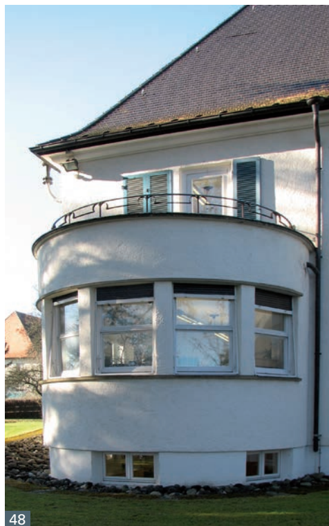
Abb. 48 und 49 Rottweil, Oberndorfer Straße 73. Vertikalschiebefenster sind an diesem Gebäude nur dort eingebaut, wo es aus Raum- und Nutzungsgründen wie zum Beispiel in dem halbrunden Salomanbau mit Terrasse sinnvoll erschien.
