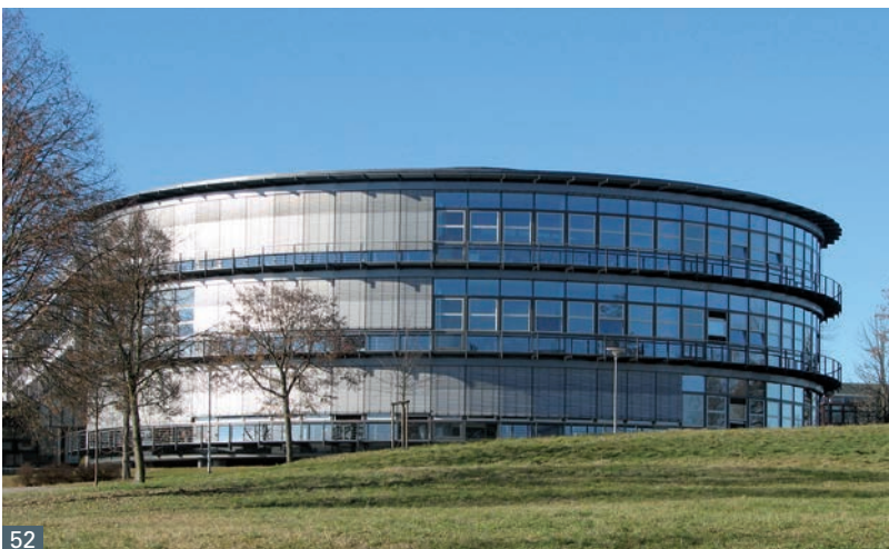
Abb. 52 und 53 Rottweil, Berufsschulzentrum Heerstraße, Architekt: a.planmory osterwalder und filmo GmbH, Stuttgart
