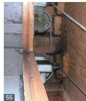
Abb. 55 Rollen und Seilzüge beim historischen Vertikalschiebefenster
