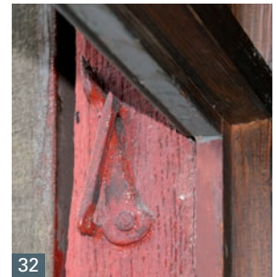
Abb. 32 Sichelartig gebogener Beschlag zur Arretierung der Läden im geschlossenen Zustand
