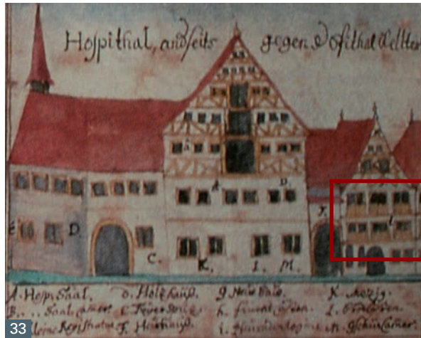
Abb. 33 Esslingen, Pfleg Hof um 1530. Verschluss der Öffnungen teilweise bereits mit Ziehläden.
