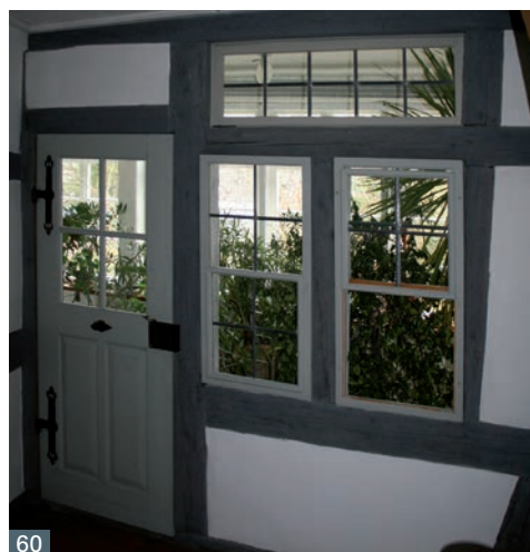
Abb. 60 Rottweil, Hochturm-gasse 4, Vertikalschiebefenster im Treppenhaus
