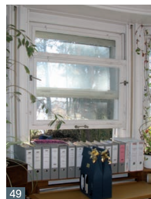
Abb. 48 und 49 Rottweil, Oberndorfer Straße 73. Vertikalschiebefenster sind an diesem Gebäude nur dort eingebaut, wo es aus Raum- und Nutzungsgründen wie zum Beispiel in dem halbrunden Salomanbau mit Terrasse sinnvoll erschien.
