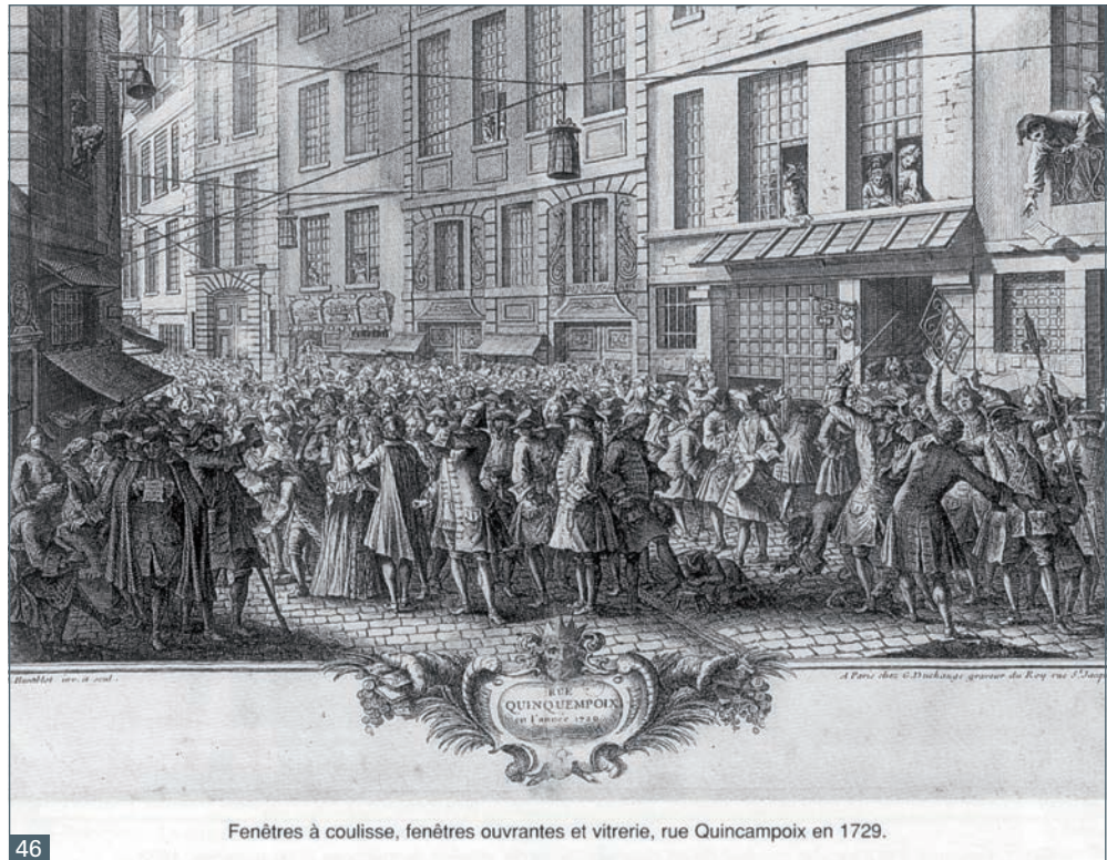
Abb. 46 Paris, Rue Quincampoix, 1729, im gesamten Straßenzug sind, deutlich zu sehen, Vertikalschie- befenster (fenêtres à coulisse) eingebaut.
