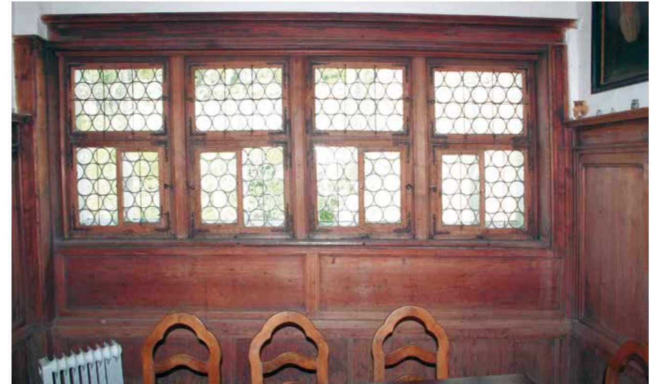
Abb. 1.23: Herrenberg, Schlossberg 1, ehemaliges Chorherrenstift, heute evangelisches Dekanatamt: Der für diese Zeit – 1577 – ausgereifte Fensterverschluss erstreckt sich über die gesamte Außenwand. Er verfügt über Drehflügel sowie einen zusätzlichen Lüftungsflügel und außen angebrachte Ziehläden.
