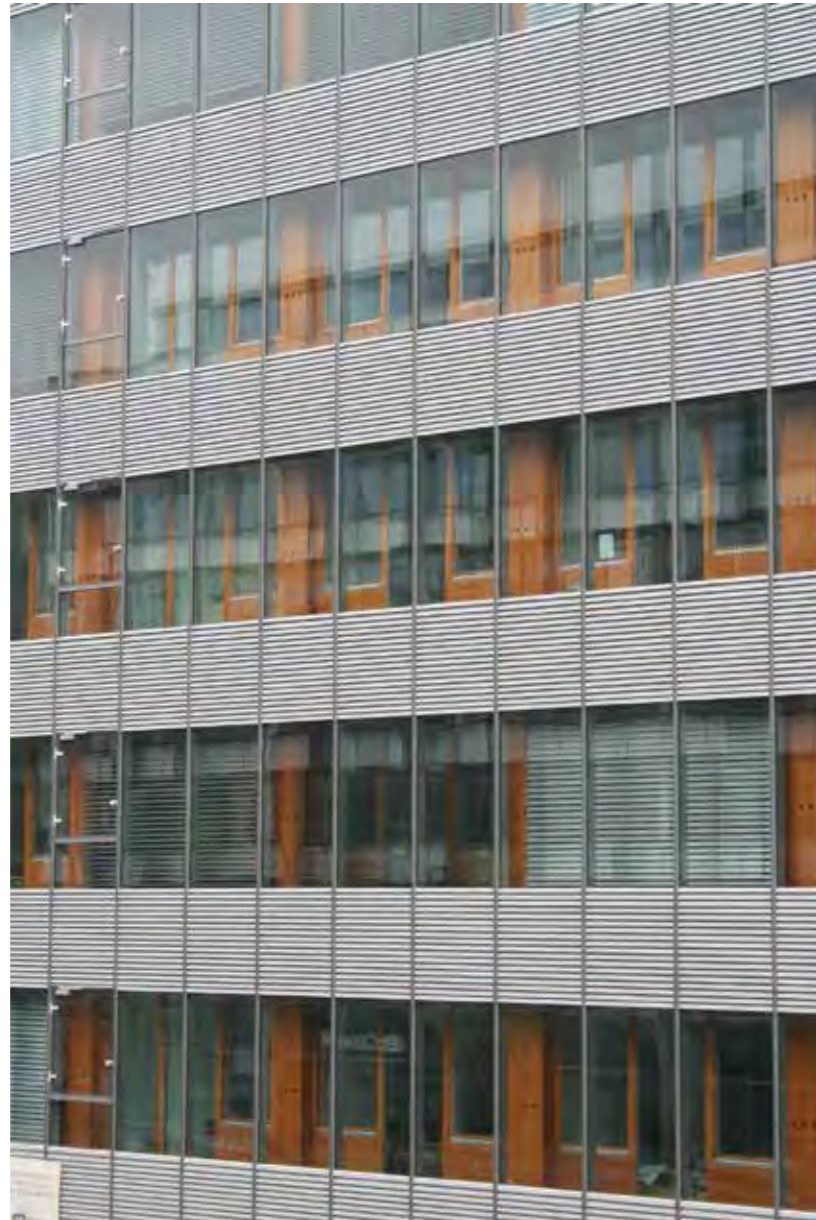
Abb. 1.56: Moderne Primär- und Sekundärfassaden als Fortschreibung historischer Doppelverglasungen in Form von Permanent- und Vorfenstern zählen heute zu den Architekturhighlights, die den Schall- und Sonnenschutz verbessern und die Energieeffizienz optimieren.
