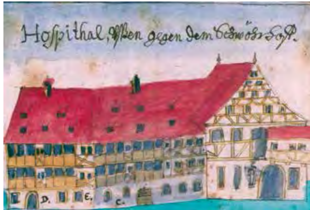
Abb. 1.33: Nordansicht des ehemaligen Katharinenhospitals in Esslingen, einer der insgesamt 10 Pflöghöfe, die bis ca. 1350 innerhalb der Stadtmauern Esslingens entstanden und die klösterliche Präsenz in der Stadt dokumentieren: Ziehläden gehörten bereits gegen 1350 zum baulichen Standard repräsentativer Gebäude; über den eigentlichen Fensterverschluss gibt die Abbildung keine Auskunft. (Quelle: Stadtarchiv Esslingen am Neckar)
