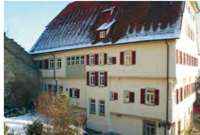
Abb. 1.35: Herrenberg, Schlossberg 1, evangelisches Dekanatamt: Um 1440 als Chorherrenstift erbaut, war der Bau von 1536 bis 1749 Residenz der Obervögte, anschließend Wohnung für den Superintendenten und die Dekane.
