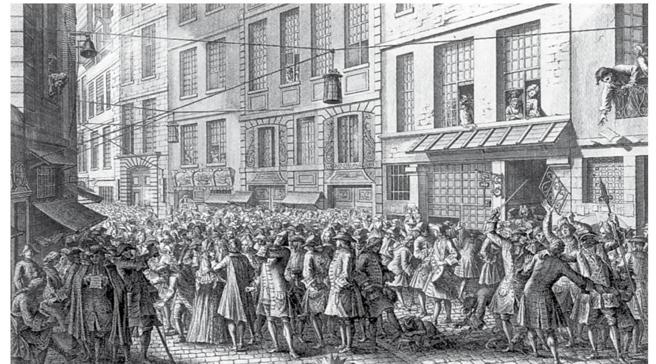
Abb. 1.55: Paris, Rue Quinquepoix, 1720: Im gesamten Straßenzug sind Vertikalschiebefenster zu erkennen. (Quelle: Fleury, 1997, S. 13)
