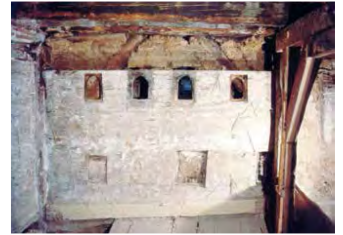
Abb. 1.13: Esslingen, Hafenmarkt 8, zweites Obergeschoss: Lichtöffnungen einer Bohlenstube aus der zweiten Hälfte des 13. Jahrhunderts: Diese Bohlenwand war ursprünglich eine Außenwand und wurde hier in Zweitverwendung eingesetzt. (Quelle: Ewald/Köhle-Hezinger/Könekamp, 1991, S. 35)
