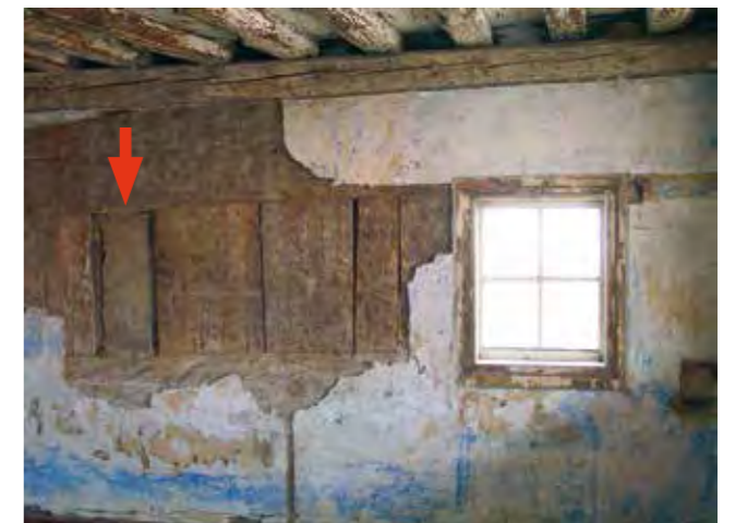
Abb. 1.14: Leutkirch, „Gotisches Haus“, erbaut 1377, Bohlenstube im zweiten Obergeschoss: Links ist eine jetzt zugemauerte originale schmale bauzeitliche Fensteröffnung mit Fensterfalz zu erkennen (siehe Markierung); die rechte Fensteröffnung ist sekundär.
