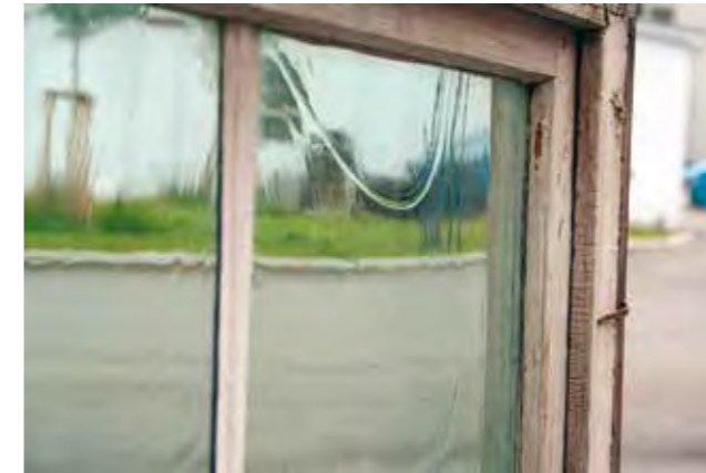
Abb. 1.42: Rottweil, „Hübscher Winkel“, Fenster aus dem frühen 18. Jahrhundert, wahrscheinlich mit Mondglasscheiben: Die Scheiben weisen Wellen, Schlieren und Blasen auf. Was damals aus begrenzten technischen und handwerklichen Möglichkeiten resultierte, ist heute ein Zeichen für historische Authentizität.
