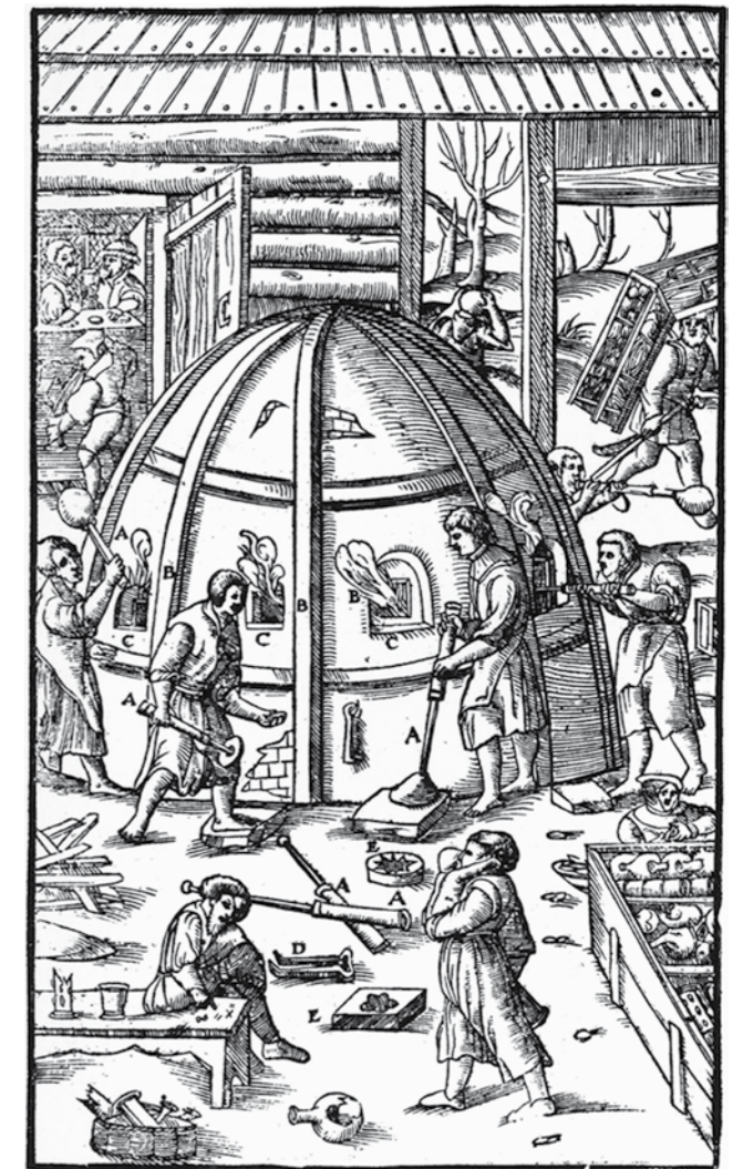
Abb. 1.44: Darstellung eines mittelalterlichen Glasschmelzofens aus Georgius Agricolae „ De re metallica “, 1556, mit einer bienenwabentartigen Form und 3 Räumen, dem Feuerungs-, Schmelz- und Kühlraum (Quelle: Glocker, 1992, S. 17)
