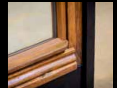
Fenster umgerüstet mit einer Isolierverglasung mit Wiederverwendung der originalen Verglasung
