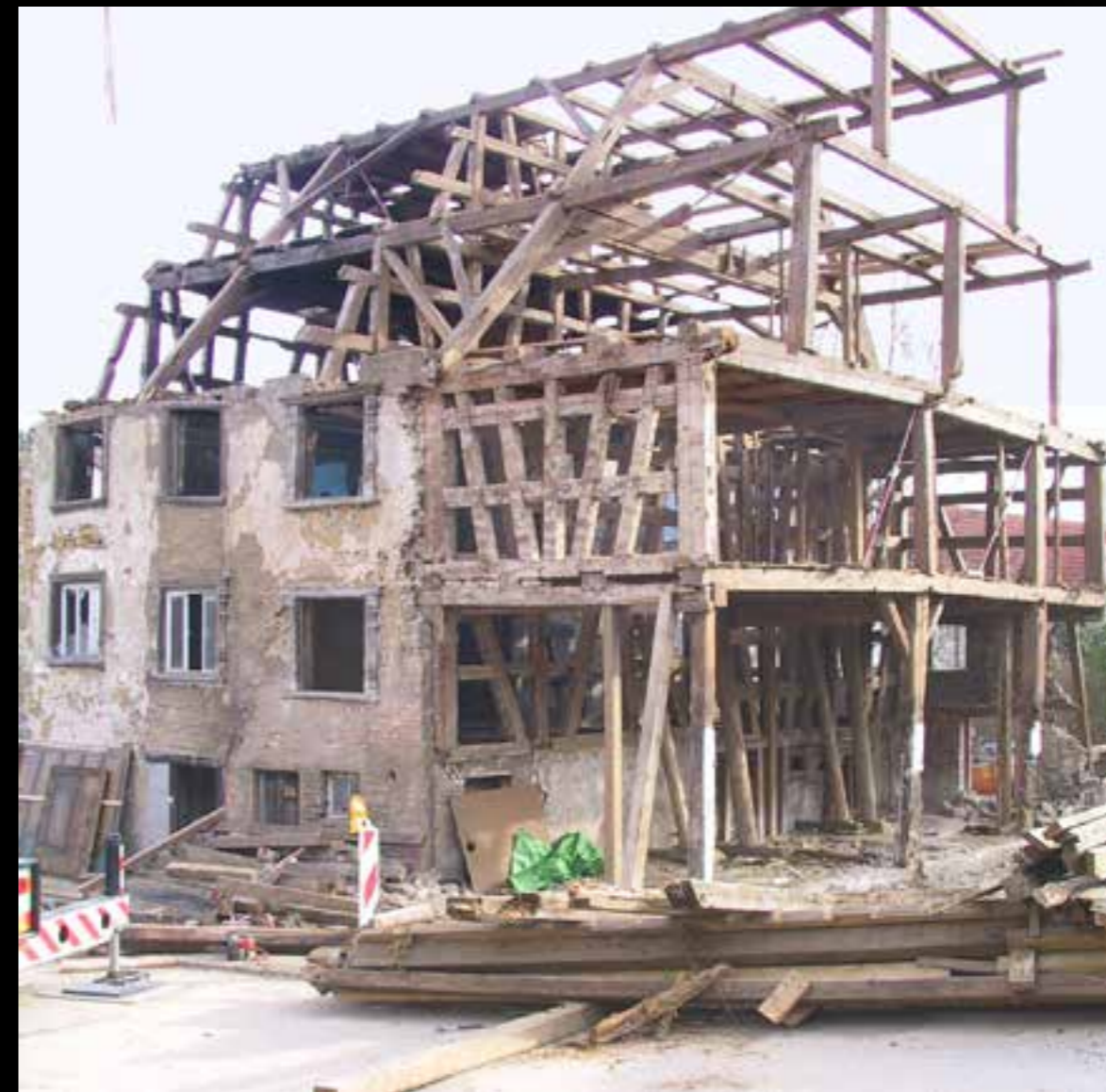
Ein Rückbau – meilenweit oder nicht weit entfernt vom Abriss. Der Wiederaufbau – ein Theater der Erinnerung, eine Kulisse für die Denkmalpflege. In diesem Fall eine Ultima Ratio der Baukulturarbeit. Denkmalschutzpreis Baden-Württemberg 2006
