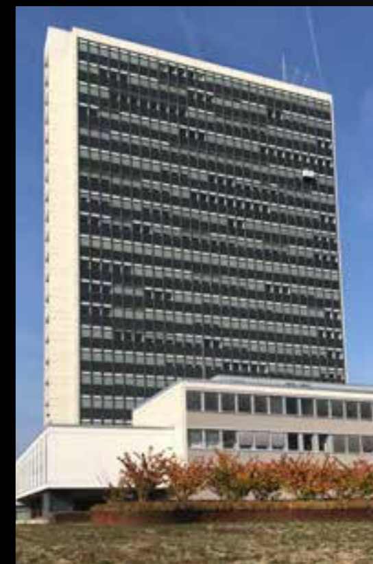
Karlsruhe, Gartenstr. 105, Verwaltungsgebäude der LVA Baden mit in den 90er Jahren erneuerter Fassade. Rein optisch und auf die Entfernung gesehen gut gelungen, aber von der bauzeitlichen Fassade ist nichts mehr übrig.
