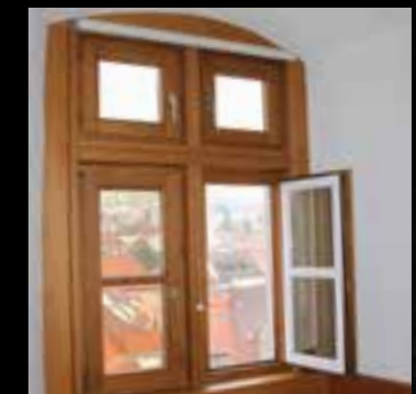
Isolierverglaste Fenster aus den 80er Jahren bleiben erhalten
