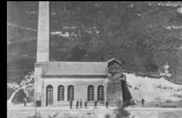
Kraftwerk des Schwarzpulverwerks um 1877 mit Schornstein und Antriebsrad auf einem hohen gemauerten Pfeiler
