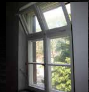
Flachkastenfenster aus den vermutlich 50er Jahren werden erneuert
