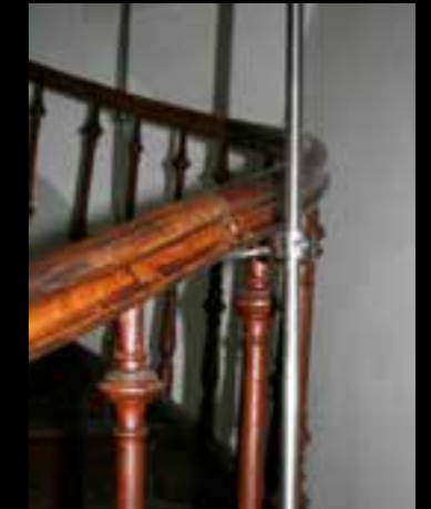
Langenargen, Schloss Montfort – Treppenhaus im Turm statisch verbessert
