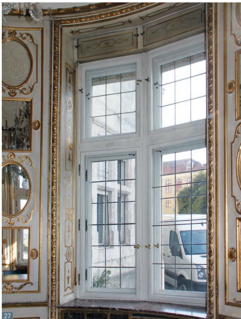
Abb. 27 Neubeuern, Schloss. Frühe Kastenfensterlösungen in den repräsentativen Räumen.
