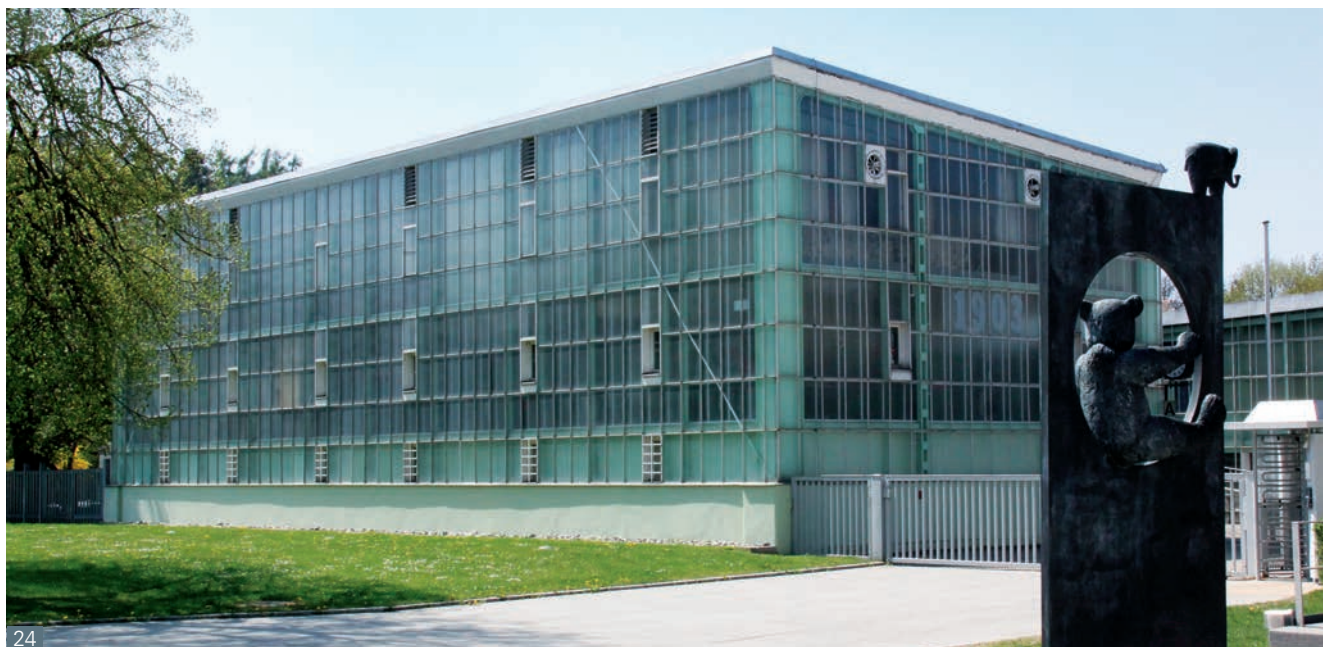
Abb. 24 Giengen an der Brenz, Produktionshalle der Firma Steiff, 1903, zweischalige Glasfassaden.
