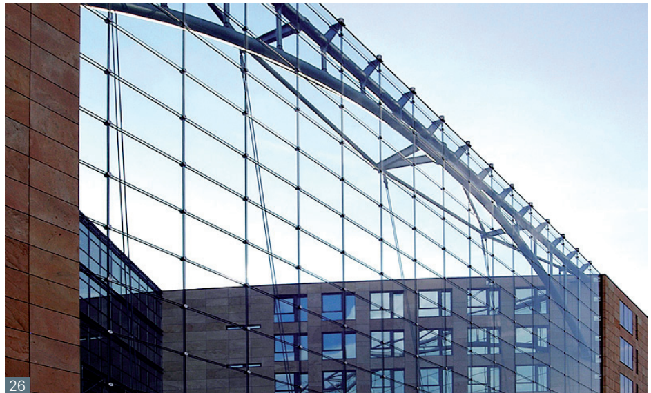
Abb. 25 Stuttgart, Hegelstraße 33. Die Kastenschichtfassade soll neben mehr Wärme auch eine schalltechnische Verbesserung bewirken.
