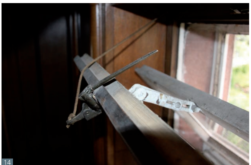
Abb. 12 Feindetailliertes Kastenfenster. Die inneren Fensterflügel sind an das Karniesprofil der raumseitigen Zierbekleidungen angepasst (S-Falz).
