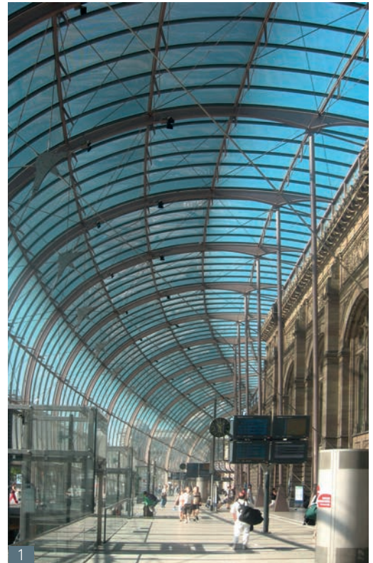
Abb. 1 Straßburg Hauptbahnhof. Gläserne Vorhalle schützt den Bestand und verbessert die Nutzung
