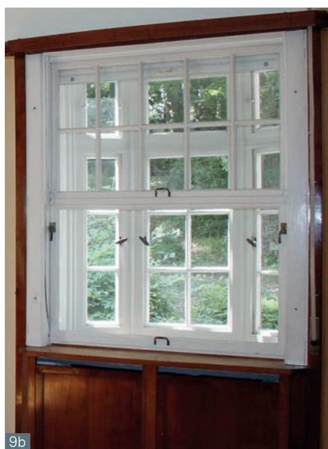
Abb. 8 Esslingen, Neckarstraße. Blumen-/Erkerfenster als eine weitere Variante des Kasten- fensters.
