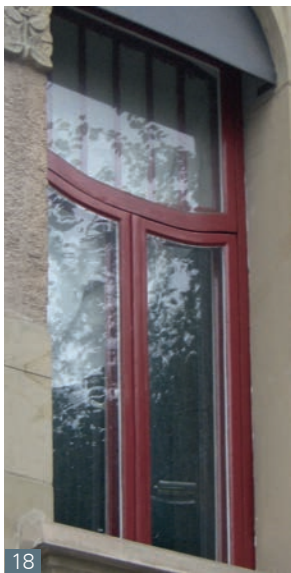
Abb. 18 Stuttgart, Schickhardtstraße 47. Stuttgarter Variante eines Kastenfensters.
