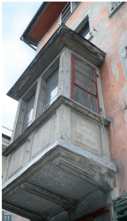
Abb. 10 Frühe Darstellung eines Kastenfensters mit Rollläden und Detaillierung einer Ent- wässerung im Sims zur Aufnah- me des Kondensats in einem unter dem Sims angebrachten Auffangbehälter.
