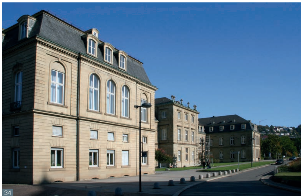
Abb. 33 Stuttgart, Neues Schloss. Energetisch verbesserte Flachkastenfenster mit dreifach Verglasung und doppelter Dich- tungsebene.
