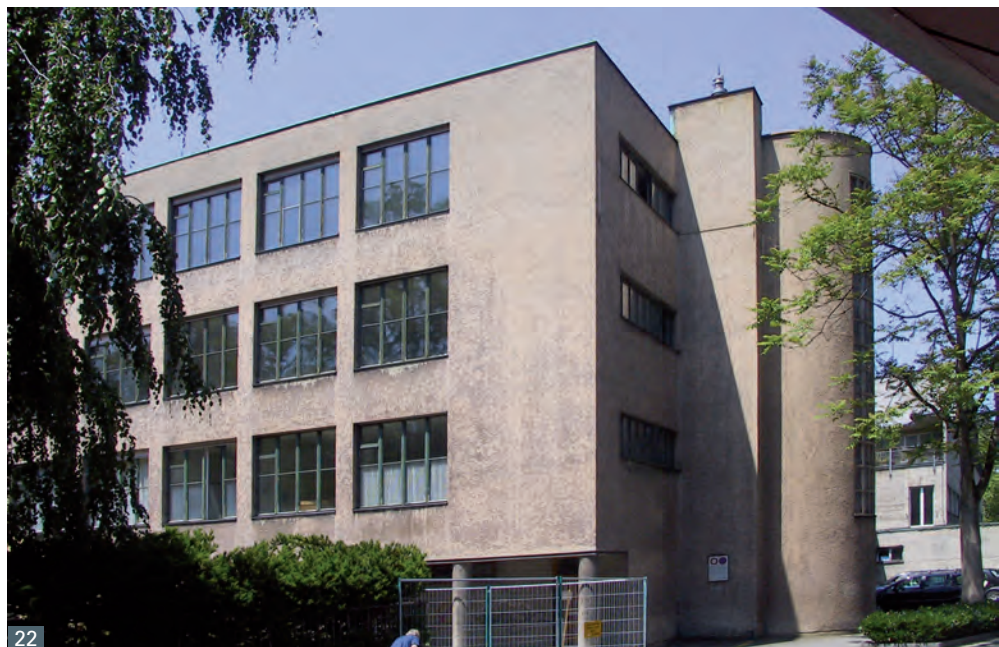
Abb. 22 Luzern, DULA-Schulhaus; bauzeitliche Verbundfenster mit wärmetechnischer Verbesserung durch raumseitigen Einbauen eines dünnen Isolierglases.
