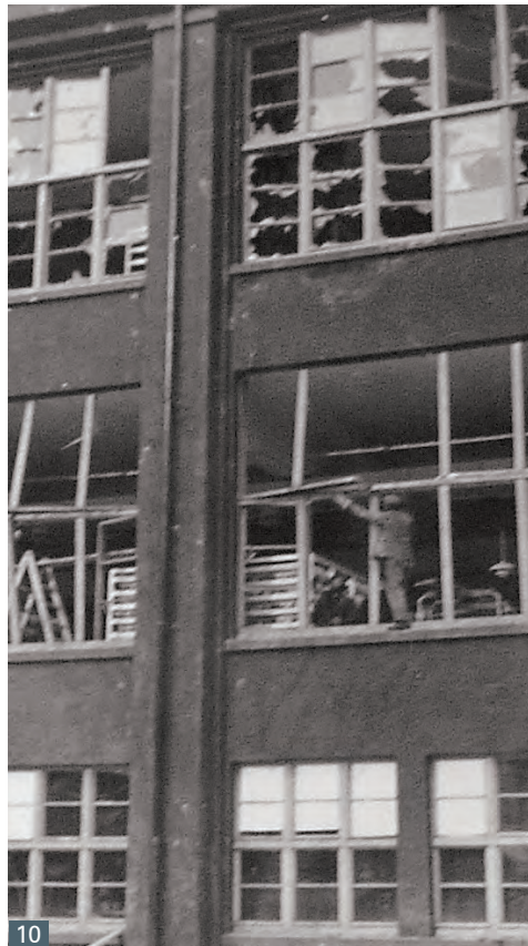
Abb. 10 Rottweil Neckartal 171, Spulerei, ehemalige Rottweiler Pulverfabrik: Zerschlagene Fenster durch eine Explosion im Jahr 1942.
