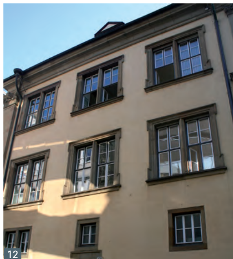
Abb. 12 Stuttgart Prinzenbau: Die Verbundfenster wurden bei dem Wiederaufbau des Gebäudes nach den Kriegszerstörungen eingebaut.
