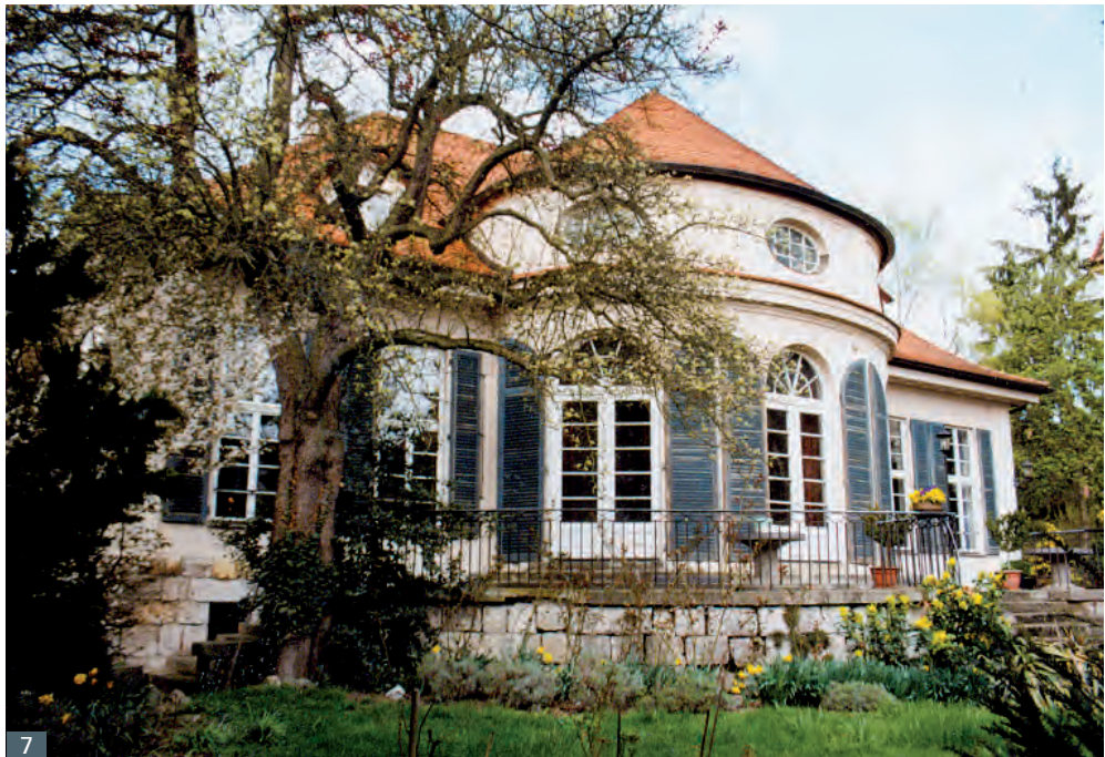
Abb. 8 Ulm Römerstraße 21, links im gewerblichen Teil Panzerfenster, rechts im Verwaltungsteil Verbundfenster.
