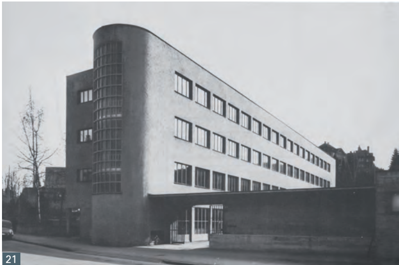
Abb. 21 Luzern, DULA-Schulhaus; komplex durchdachtes Verbundfenster.
